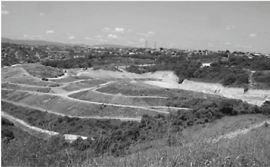
FIGURA 7 - Vista parcial do aterro sanitário de Contagem
