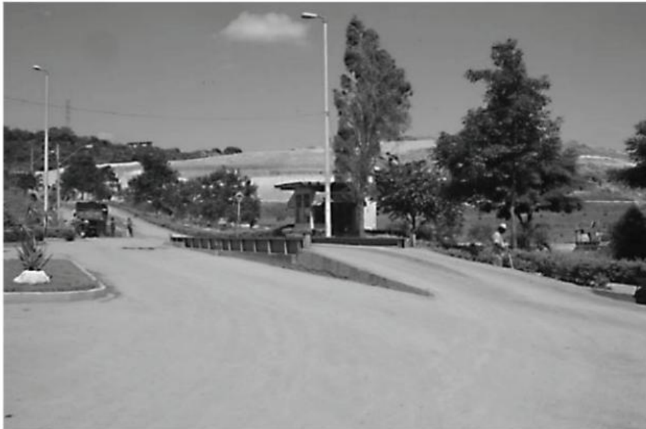
FIGURA 6 - Entrada do aterro e vista parcial da balança
