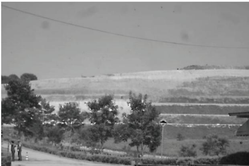
Figura 8 - Vista dos taludes com resíduo sólido já aterrado
