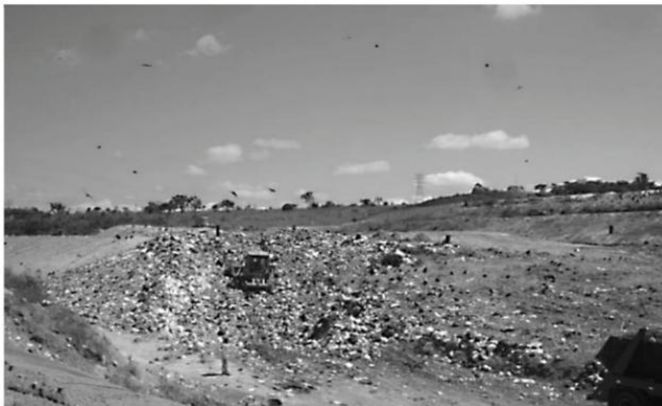
FIGURA 10 - Frente de Operação
