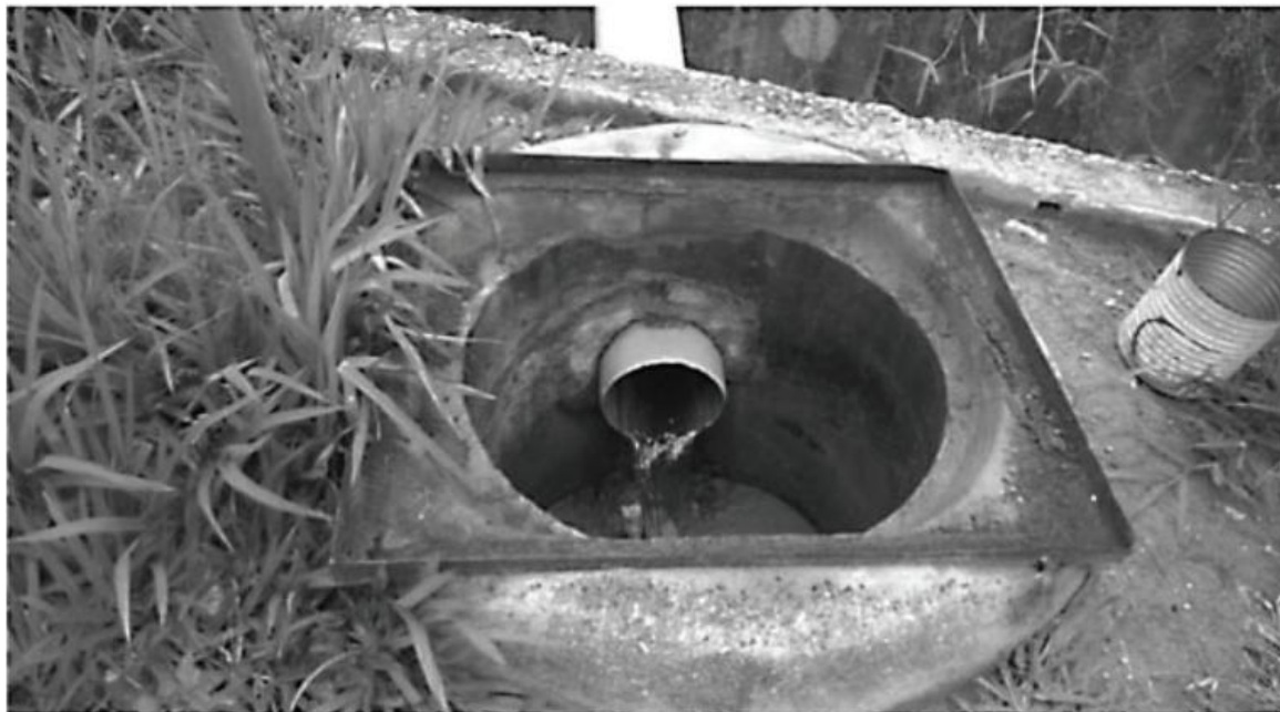
FIGURA 1 - Ponto de coleta do chorume
